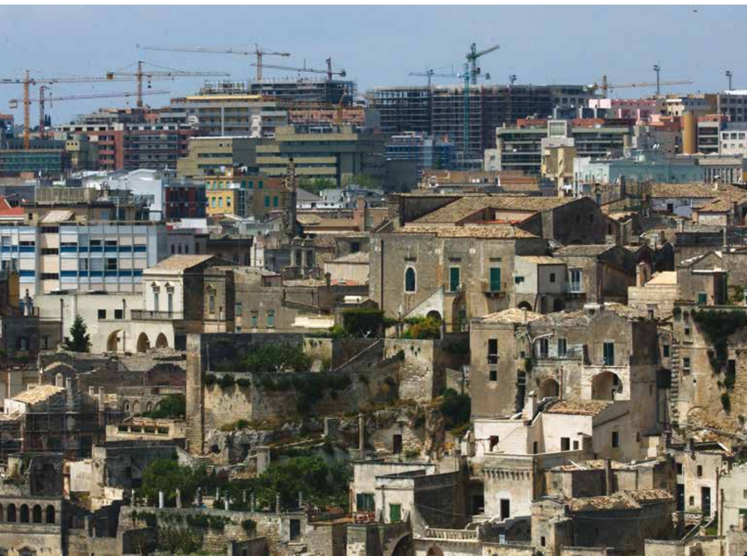
Foto 2.04 L'avanzare dell'urbanizzazione Fonte ISPRA
