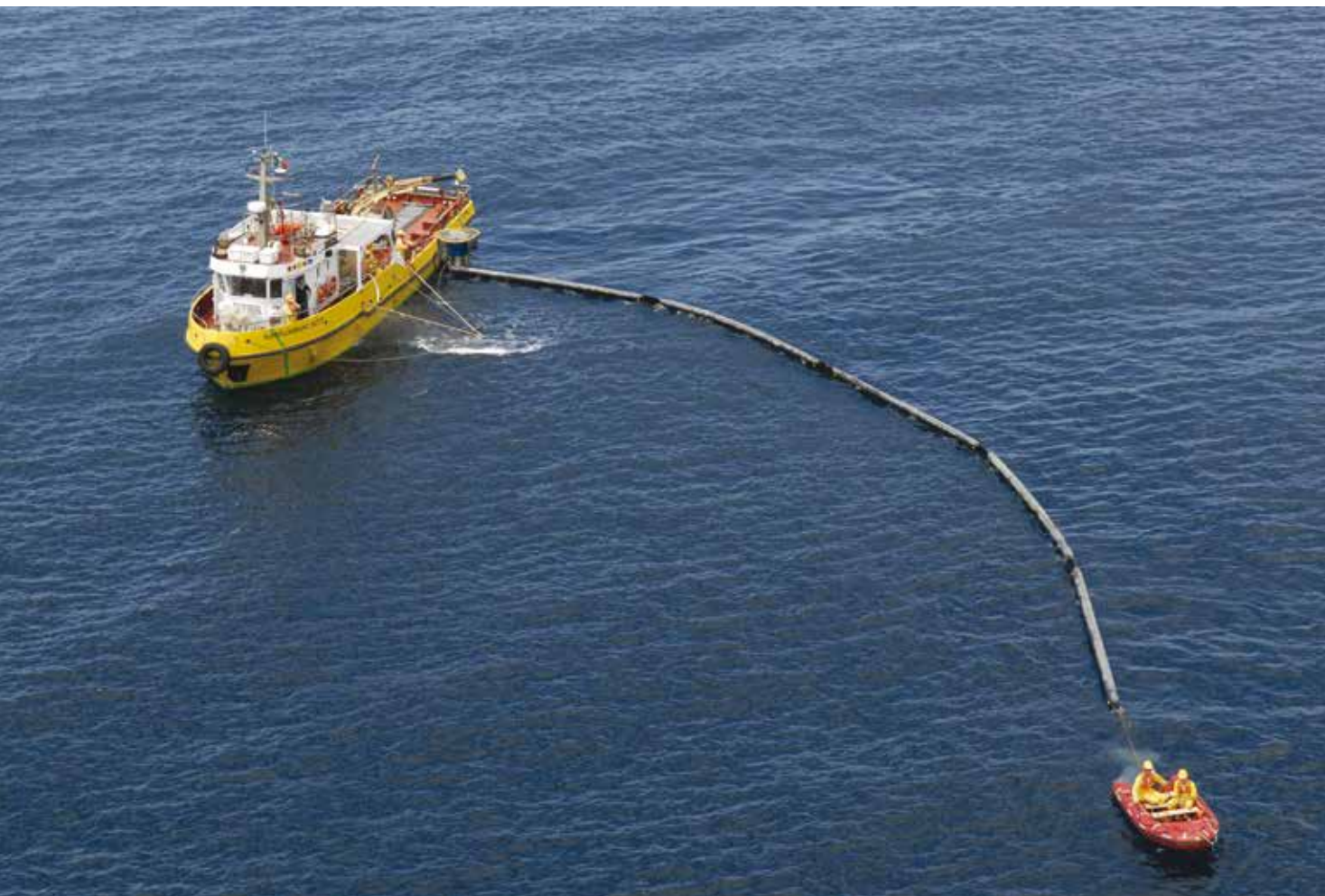
Foto 7.74 Posa di panne galleggianti Fonte Castalia Consorzio Stabile S.C.p.A.
