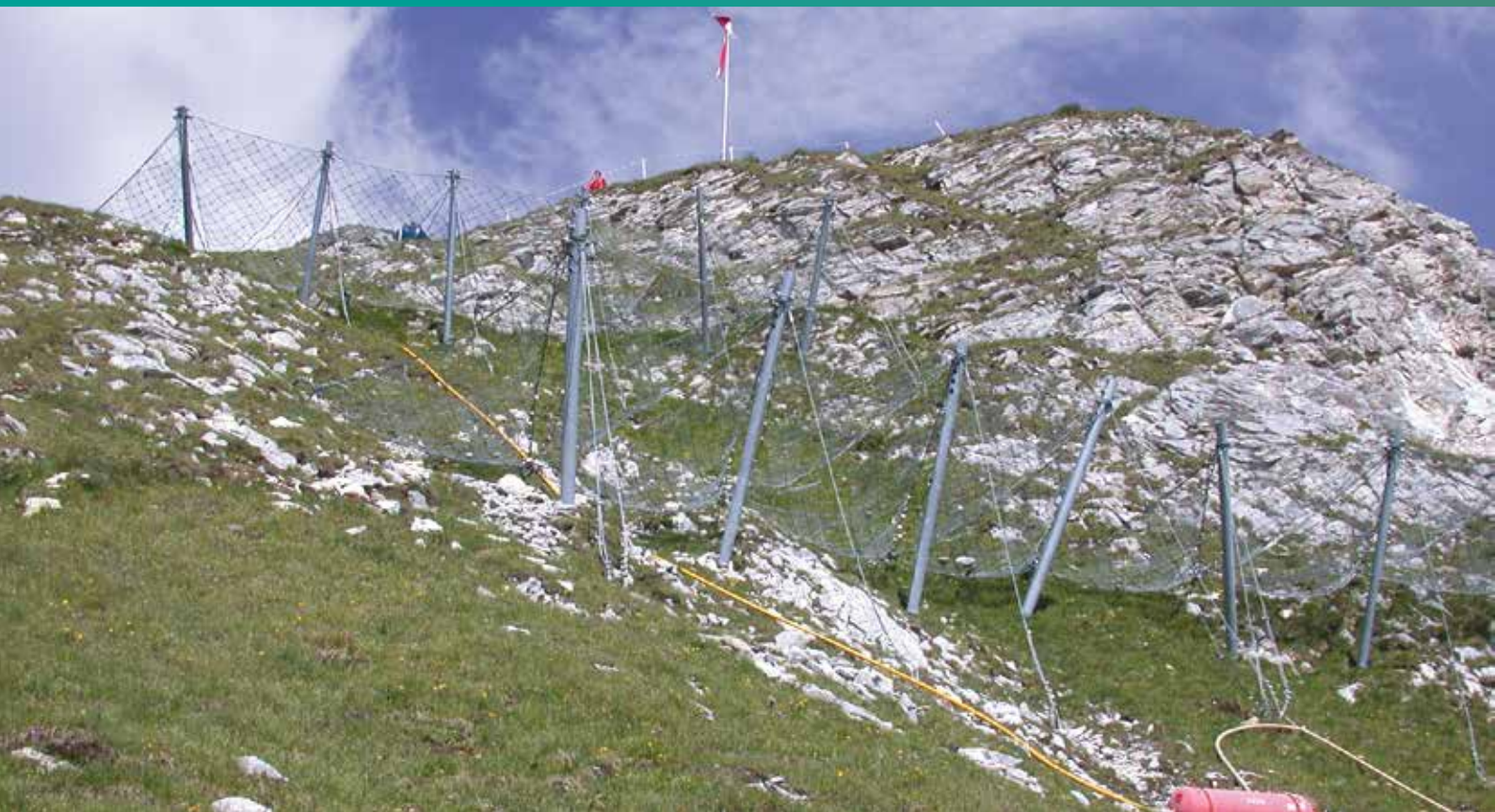
Foto 8.17 Opere in alveo Torrente Selvaspessa - Intervento 774/99 - Baveno (VB) Fonte ISPRA Elisa Brustia - Francesco Traversa - Marco Di Leginio
