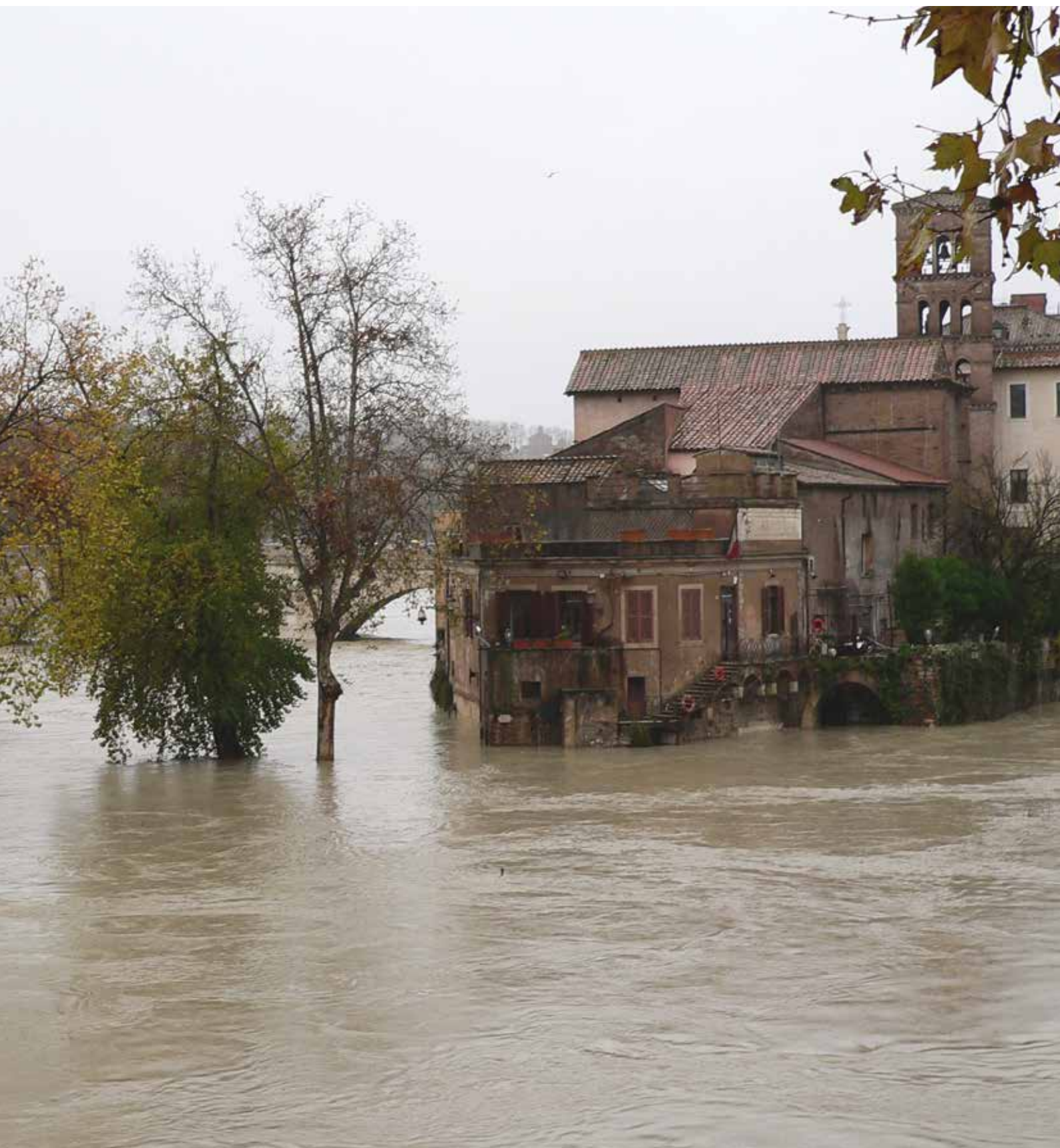
Foto 6.04 Alluvione Fonte ISPRA Franco Iozzoli
